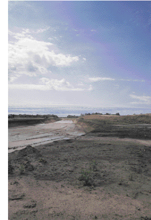
Proyecto de Saneamiento Hídrico de la Línea del Tapenagá. Inicio de conexión Bajo Hondo I y II. Chaco.
