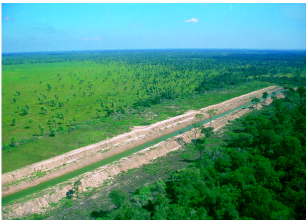
▲ Vista aérea del proyecto Tapenagá. Chaco.
