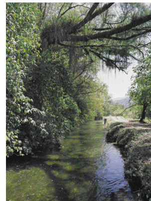
Actual toma de riego en Lules, en la zona donde se construirá el canal matriz. Tucumán.
