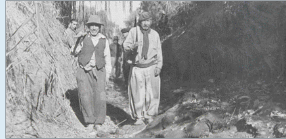
▲ Trabajadores de pala en el Canal Montecaseros (1956). Departamento de San Martín. Mendoza.
