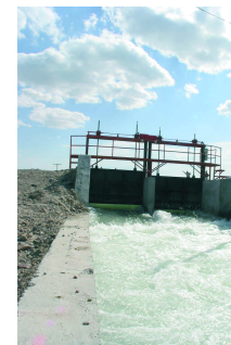
▲ Proyecto Rehabilitación del Tramo Inferior Río Mendoza, 5° y 6° tramo.
