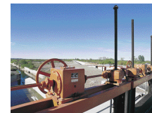
▲ Primera foto Mecanismo de compuertas en el 5° tramo del canal San Martín en el río Mendoza.
