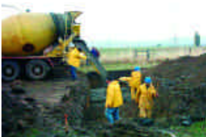
Primera y segunda fotos ▲ Construyendo canales en Trevelin.
