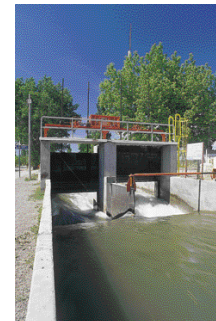
▲ Grandes compuertas sobre el canal matriz San Martín. Mendoza.
