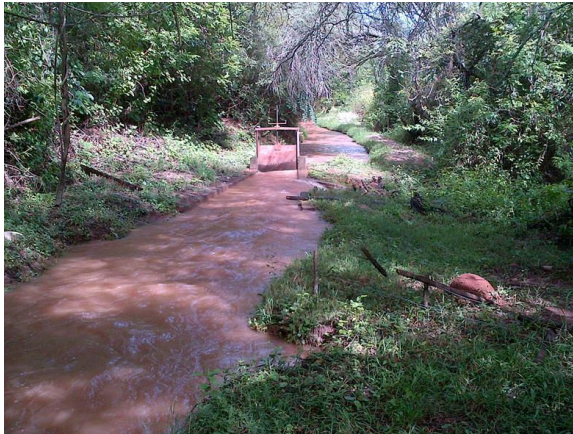
Fotografía 1 - Partidor Canal Principal. En la imagen se puede ver el canal principal que recorre la margen sur del arroyo Colorado y hacia la izquierda se encuentra flanqueado por una barranca natural. A la altura de la compuerta que se puede observar en la imagen, es el punto aproximado donde iniciaría el sifón y correría sentido sur-norte (hacia la derecha en la fotografía).
