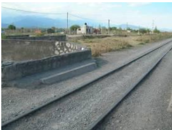
Zona en donde las obras aluvionales cruzan perpendicular a las vías del FFCC
