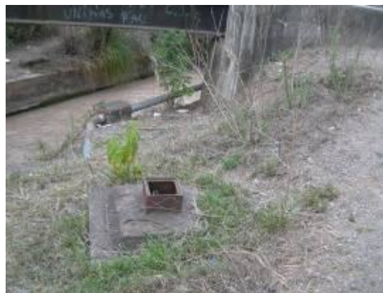
Zona de acueducto perpendicular a traza de tuberías
