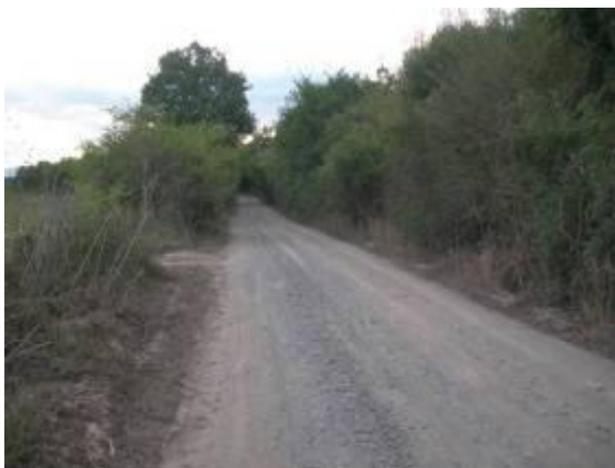
Vista representativa de la mayor cantidad de sitios a intervenir con redes presurizadas
